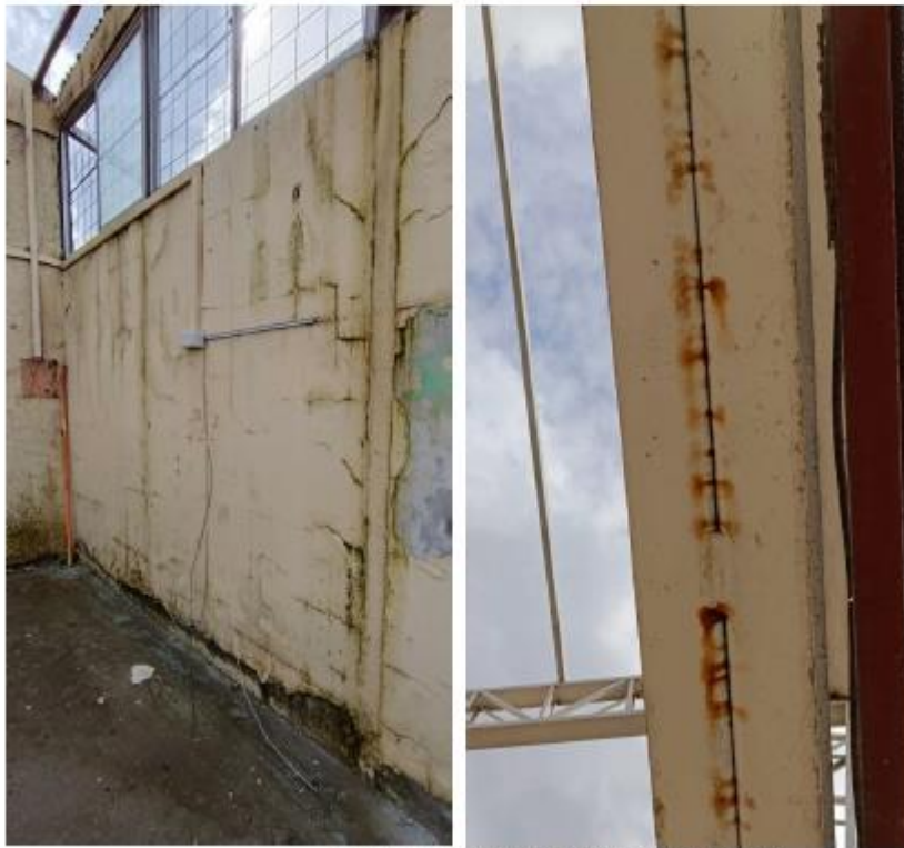
Situación de muros y estructura metálica construida
