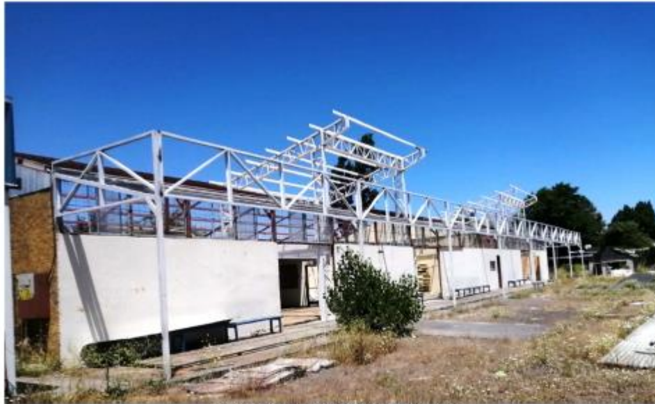
Estructura Modificación de Cubierta ejecutada
