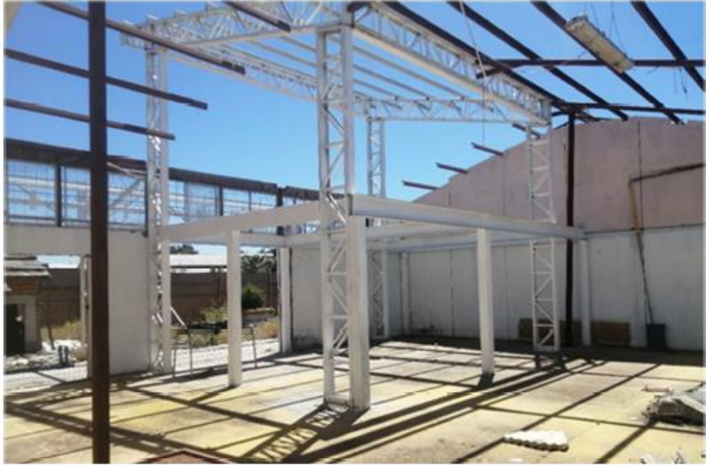
Estructura de Entrepiso incompleta
