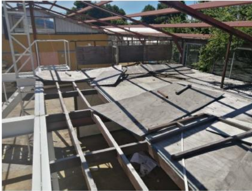
Entrepiso existente a intervenir
