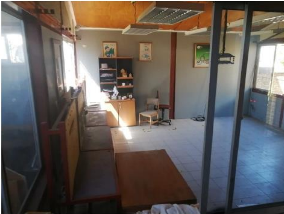
Interior Taller de Estructuras Sala
