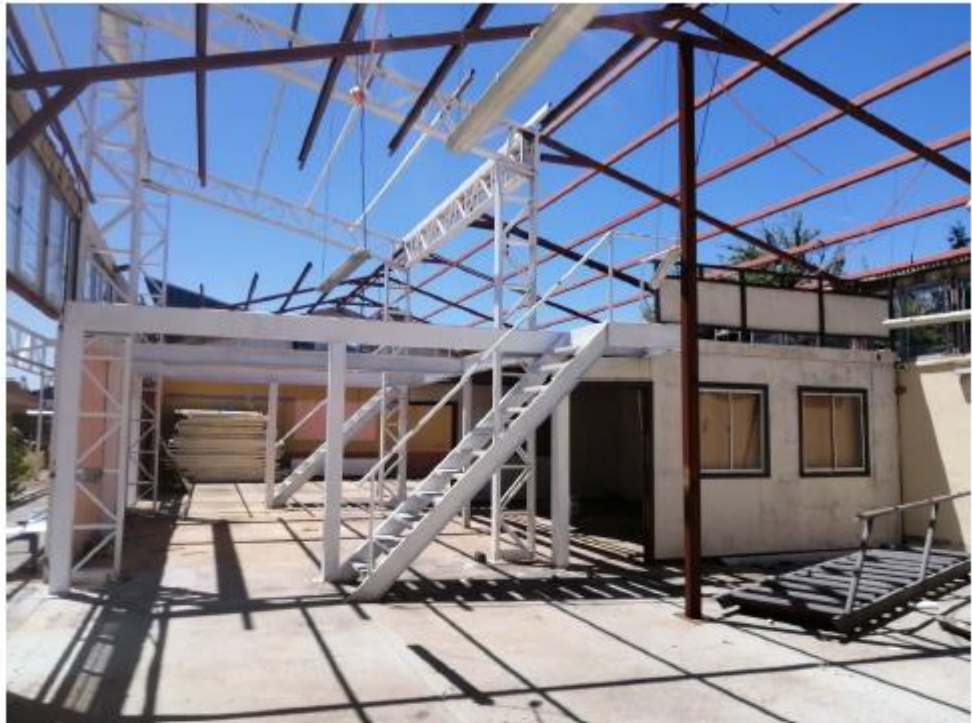
Entrepiso Taller Electricidad a medio ejecutar
