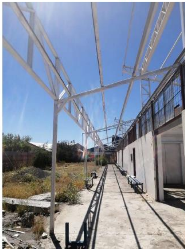
Pasillo Estructura de frontón ejecutada
