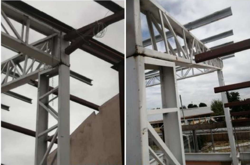
Reforzar y completar estructura de techumbre
