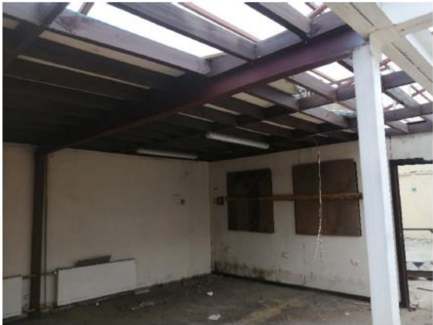
Entrepiso a completar su construcción
