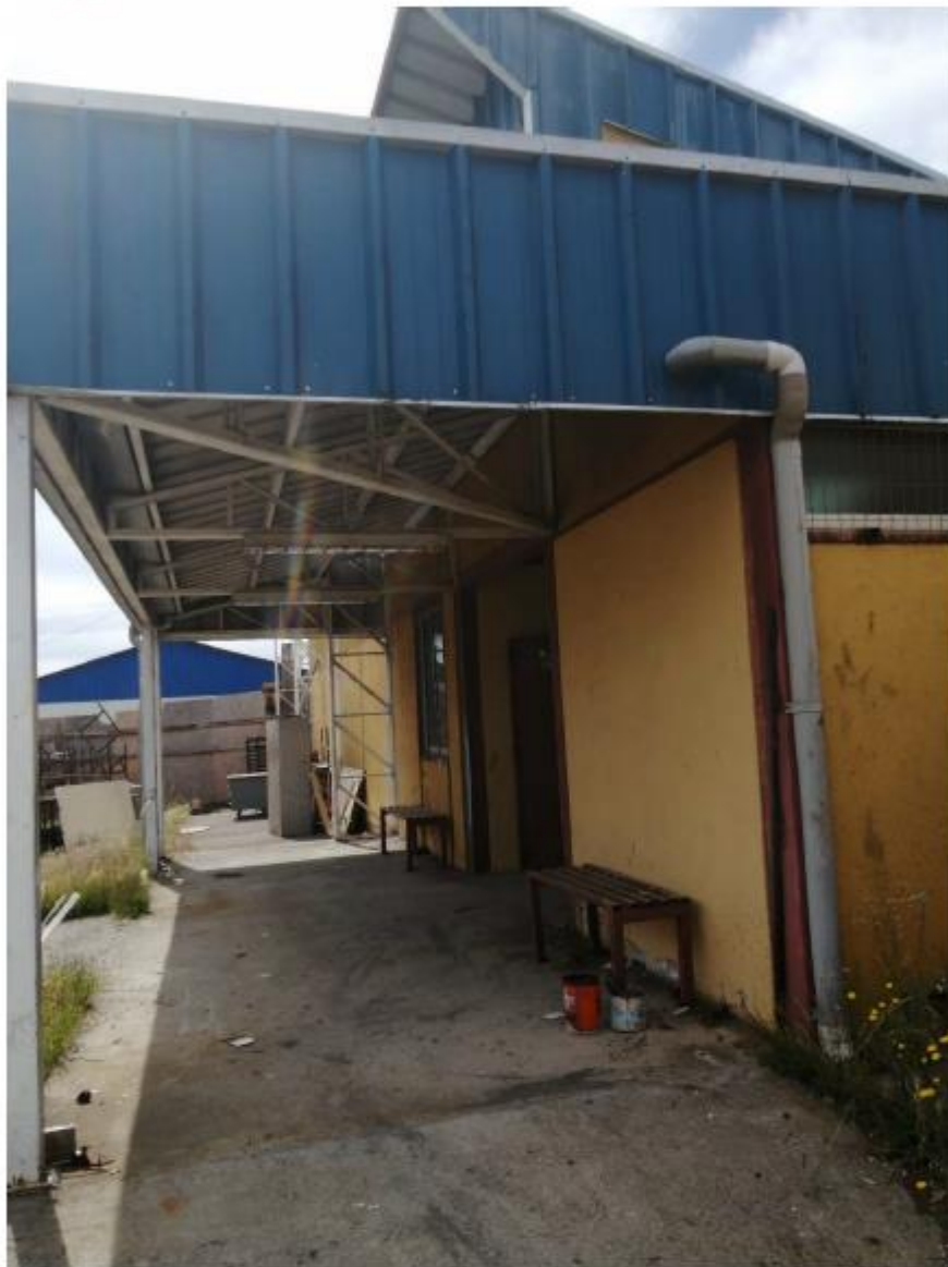
Pasillo Fuera Taller Estructuras
